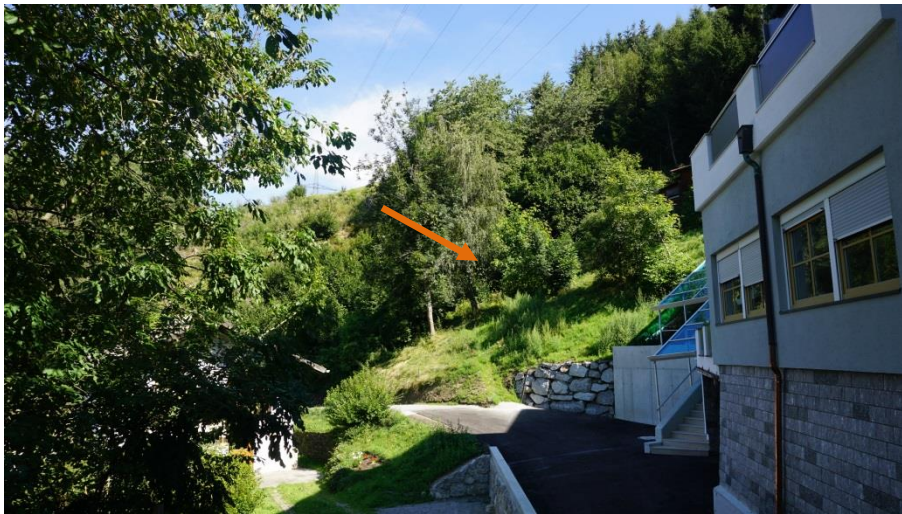
Foto 1: Geplante Erweiterung im Bereich Hennenboden (Blickrichtung N).
